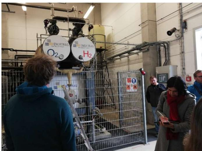
Ein Enertrag-Mitarbeiter erklärt die Funktionsweise des Elektrolyseurs, der Wasserstoff und Sauerstoff trennt.
